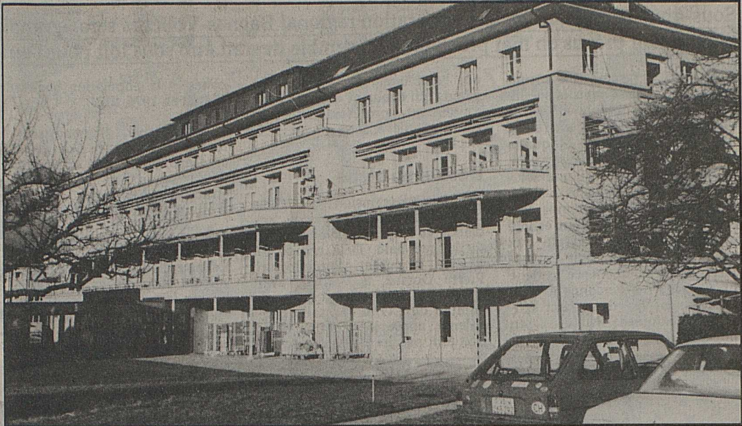
L'hôpital d'Aigle: son service maternité a été entièrement remodelé.
