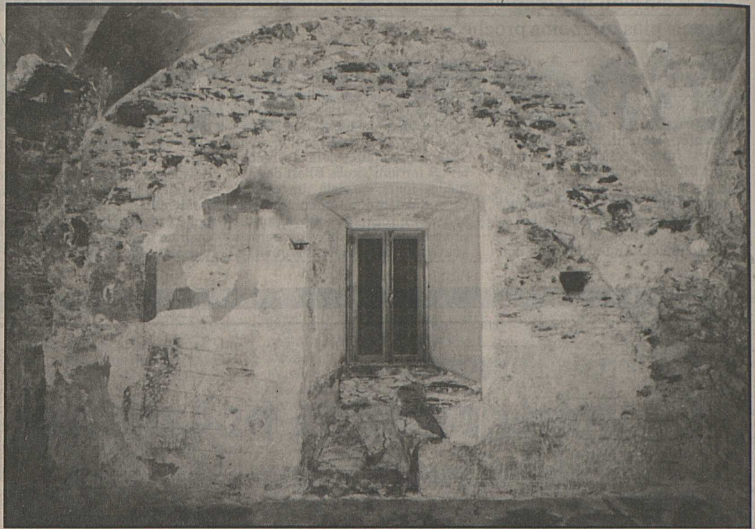
Vue générale du mur est de la sacristie.
