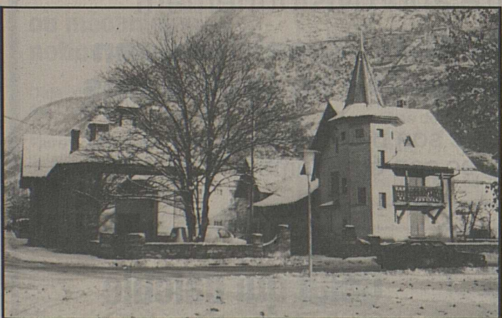
Les anciens abattoirs avec à droite la maison du Clocheton. Les deux immeubles seront réunis par une construction vitrée.
