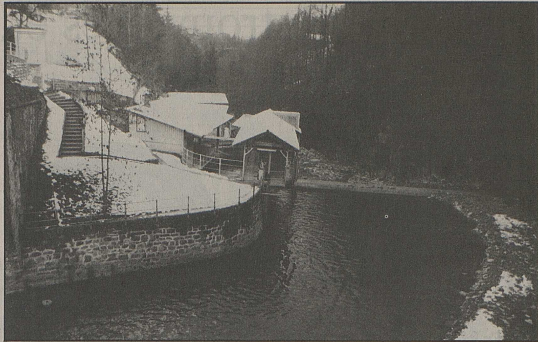
Le barrage du pont du pas de Troistorrents, point de départ des canalisations alimentant l'usine de la Vièze à Monthey.
