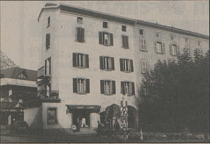
C'est dans cette maison située au sommet de la place Centrale, vis-à-vis de l'hôtel de ville, que l'incendie s'est propagé.
