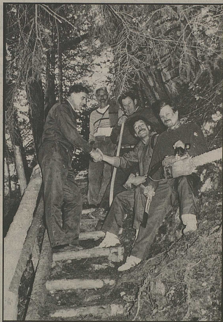
Les travaux de réfection sur le tracé du sentier nature.
