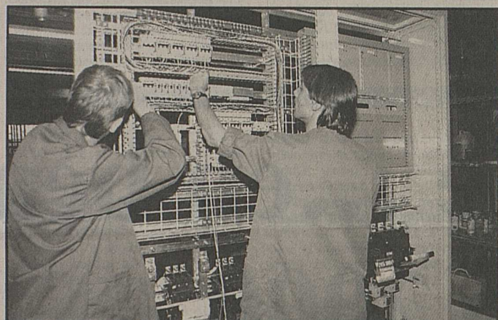
Montage d'un tableau électrique.
