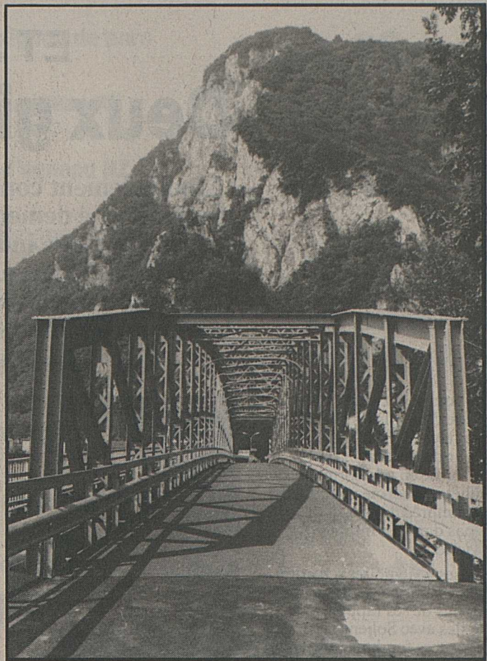
Le pont de la Porte-du-Scex, refait à neuf et rouvert au trafic aujourd'hui dès midi.
