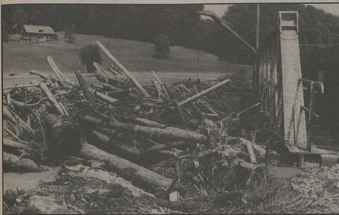
A Burgistein (BE), les eaux charriant moult épaves ont emporté un pont de chemin de fer. AP
