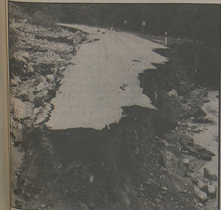
La route de Moléson-Village a été emportée. Il a fallu instaurer un pont aérien pour évacuer les vacanciers. ASL
