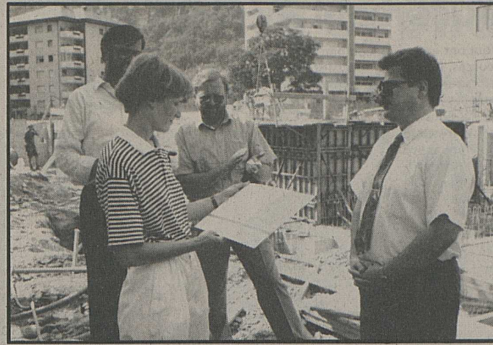
Remise du chèque de 10000 francs sur le chantier du home de Brigue.
