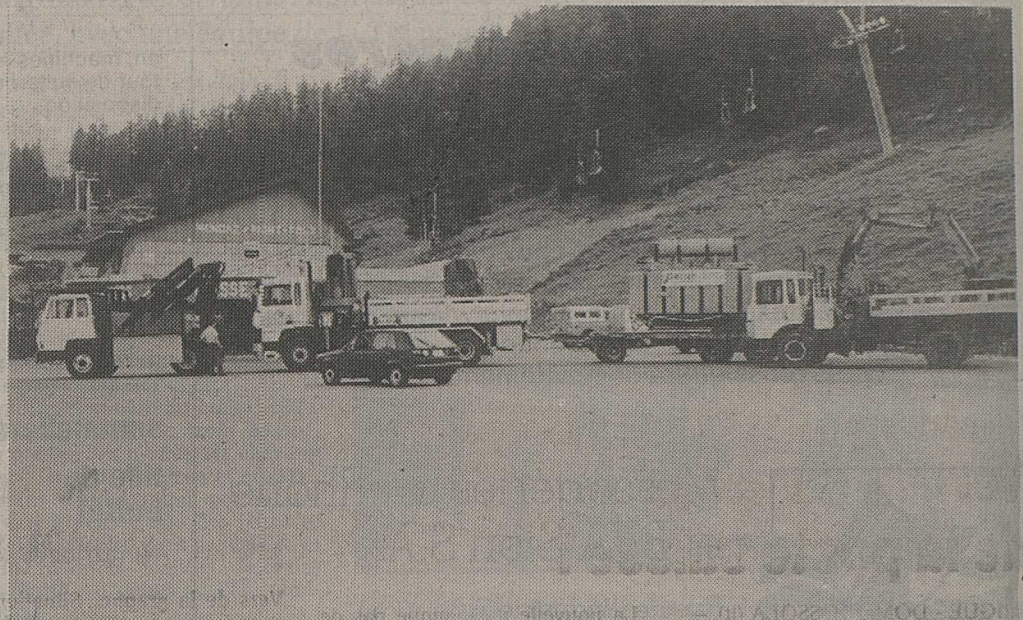
Un convoi de plus de 80 tonnes est arrivé hier sur le plat de Siviez avec 3 camions de l'entreprise GLASSEY S.A. à Martigny équipés respectivement de grues 72T/m. - 27T/m. - 17T/m.
