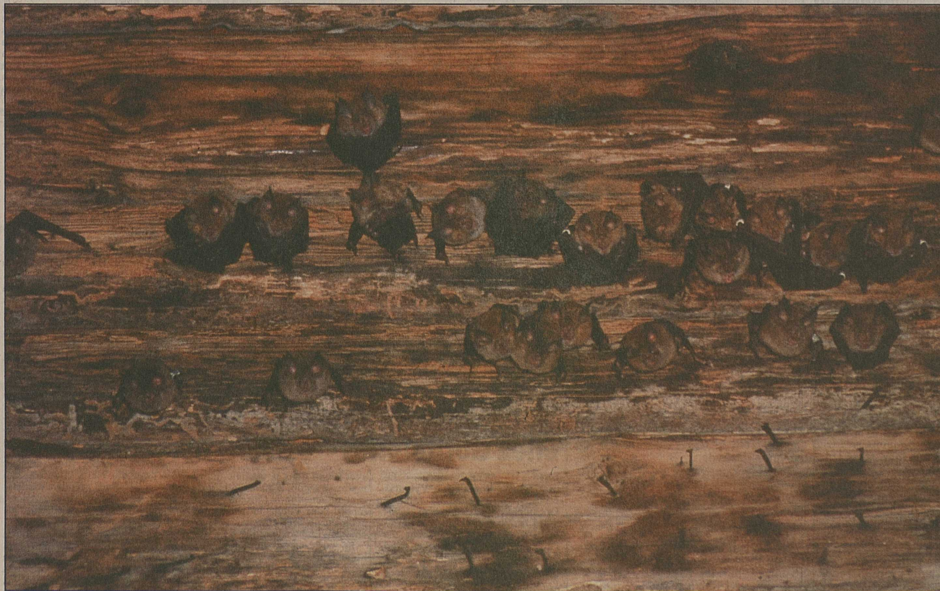
La colonie de grands rhinolophes de Vex avant les travaux de restauration. On devine les femelles «suitées» qui dissimulent leur jeune sous leurs ailes; celui-ci s'agrippe fortement à leur poitrine et peut ainsi être transporté dans un autre gîte en cas de danger.
