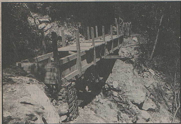
Un autre ouvrage de l'armée, une passerelle pour piétons de 12 mètres entre Vex et Euseigne.
