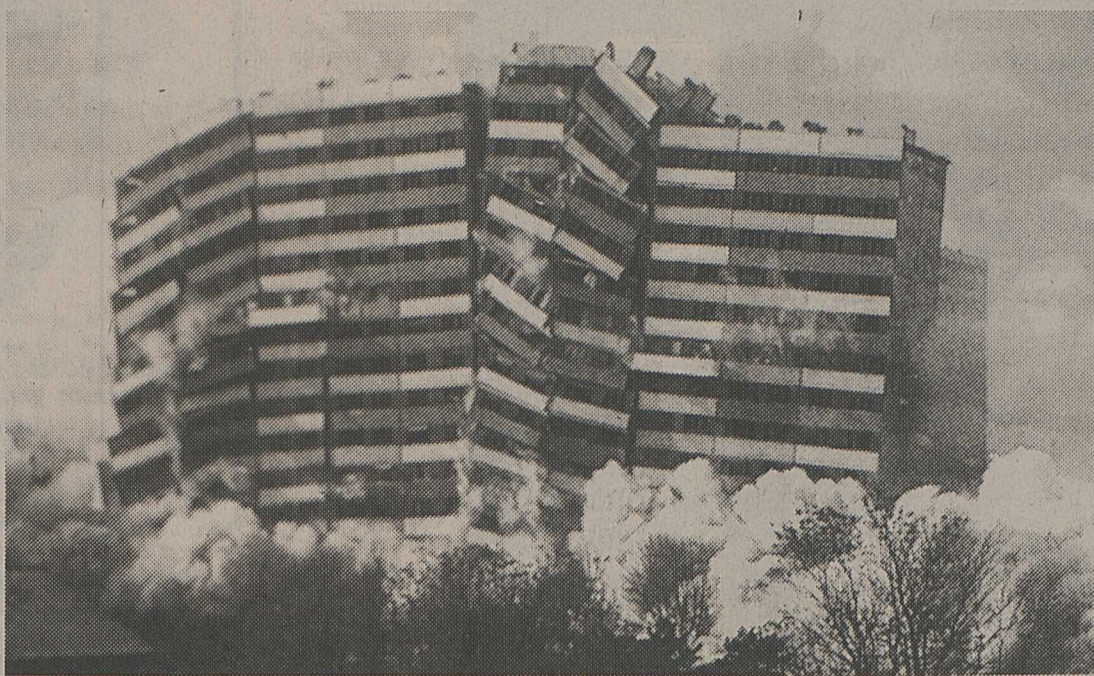
La réhabilitation passe parfois par la démolition.
