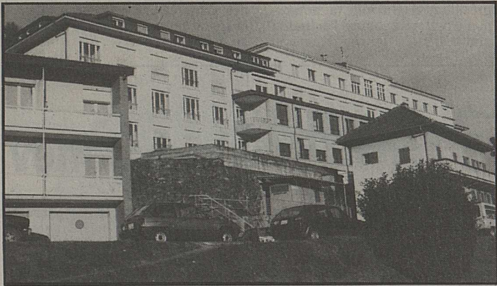
L'hôpital de district de Monthey: les modernisations vont bon train.
