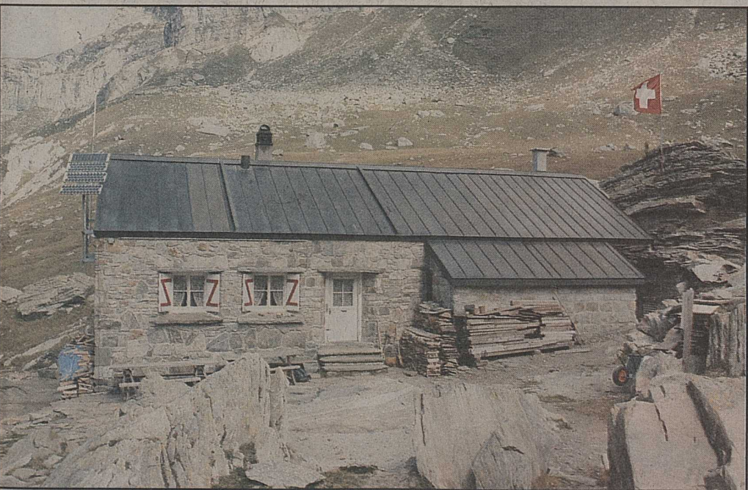
La cabane du Binntal, agrandie et restaurée.
