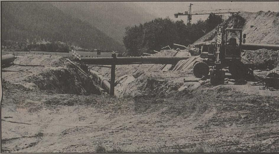
Vue des travaux actuellement en cours à proximité de la gare d'Oberwald, où l'ouvrage consiste tout d'abord à faire passer le gazoduc sous la nouvelle route, à plusieurs mètres de profondeur.
