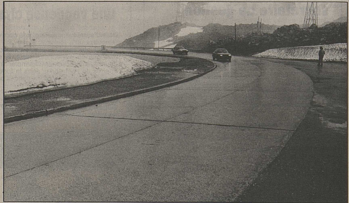
Vue du point culminant du col du Nufenen sous la tempête.
