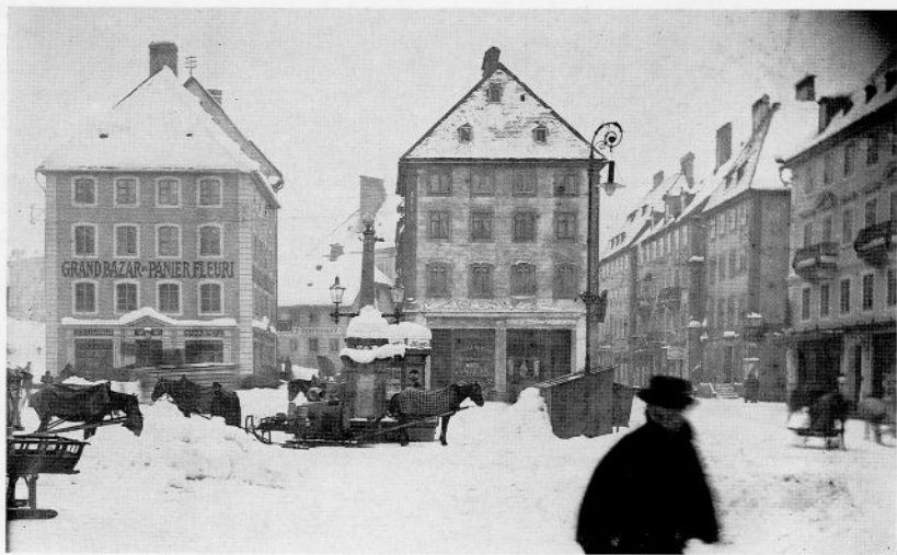
La Centrale laitière proche explique la présence des traîneaux place de l'Hôtel-de-Ville. Le monument de la République sera édifié sur l'emplacement de la fontaine.
