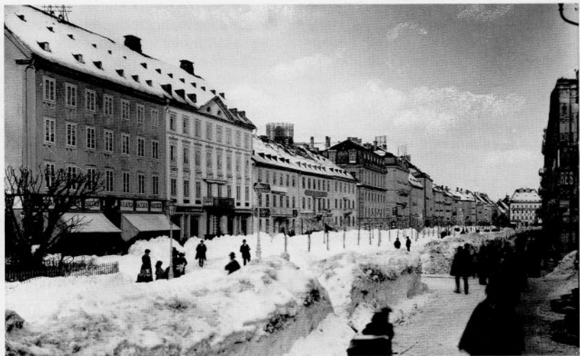
Le centre de la ville s'est déplacé vers l'ouest, le long du «Pod», avec par exemple le Grand Bazar parisien. Les arbres viennent d'être plantés et des jardins subsistent encore.
