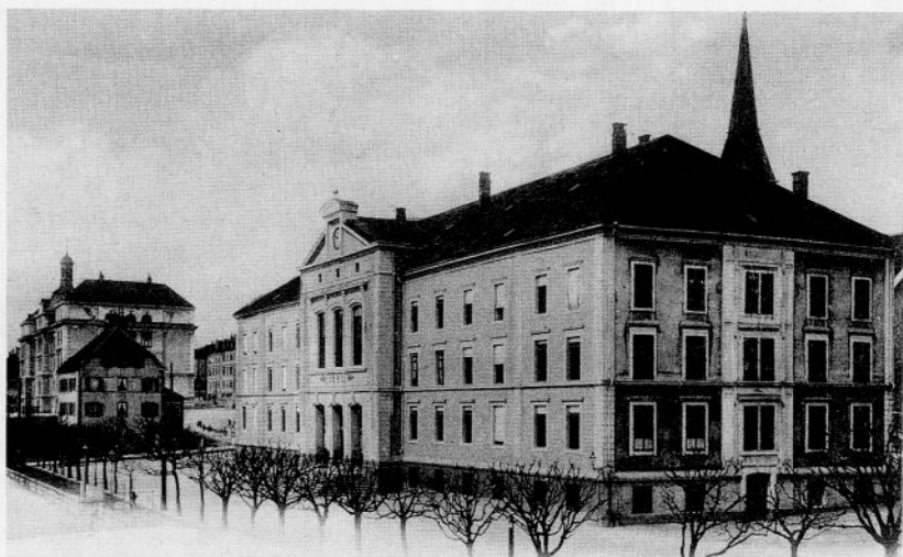
Le Collège industriel, fleuron des bâtiments scolaires de la ville, véritable «Maison de la Culture» (à gauche), et le Collège primaire, aujourd'hui disparus.
