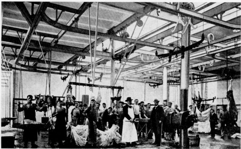
Ils avaient été prévus pour pouvoir alimenter une ville de 50000 habitants...
