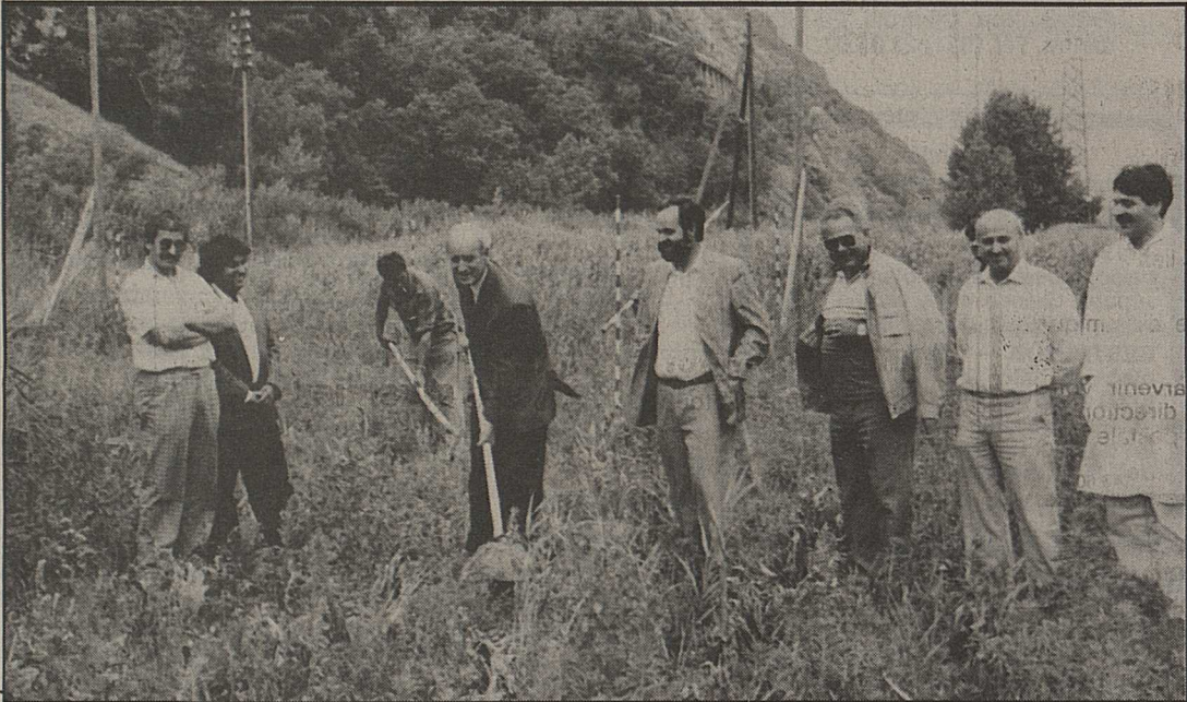
Le coup de bêche symbolique pour les nouveaux abattoirs, près de l'ancienne station du téléphérique de Mund.
