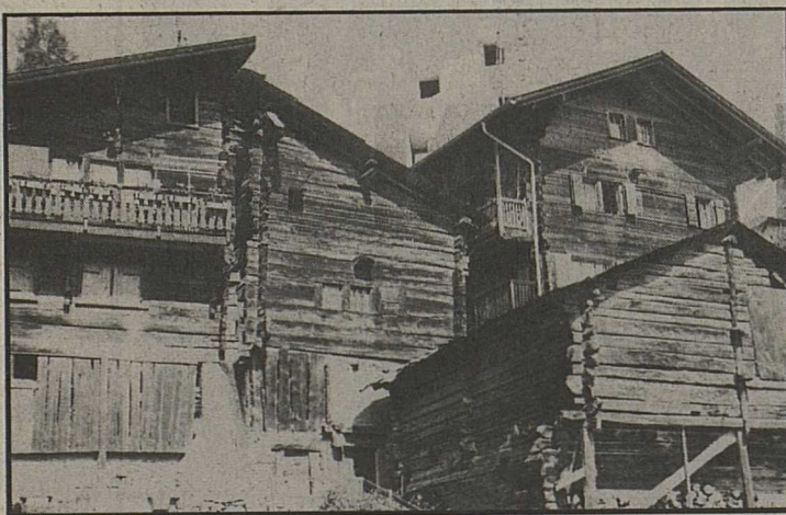
Héremence, mariage du bois et du béton. L'été 1988 s'y annonce particulièrement animé.
