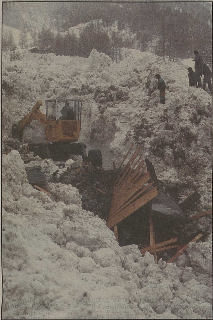
A gauche de l'engin de déblaiement, quelques débris fumants dans la neige, c'est tout ce qu'il reste de la partie supérieure du chalet.
