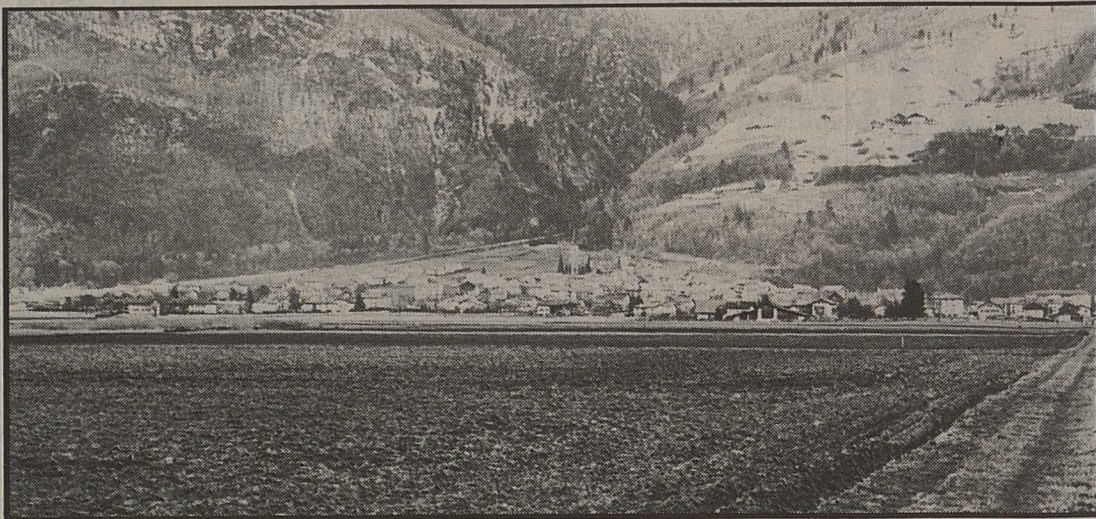
Le secteur où le chantier de la future STEP s'ouvrira le mois prochain, avec au fond, le village de Vionnaz.
