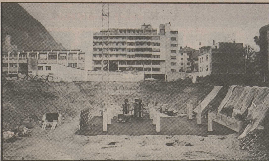
5000 m 2 de terrain: c'est l'emprise que représente au sol le futur centre commercial de la Poste. Le chantier est impressionnant. Le bras de la grue mesure 50 mètres. Le plus long jamais vu à Martigny.
