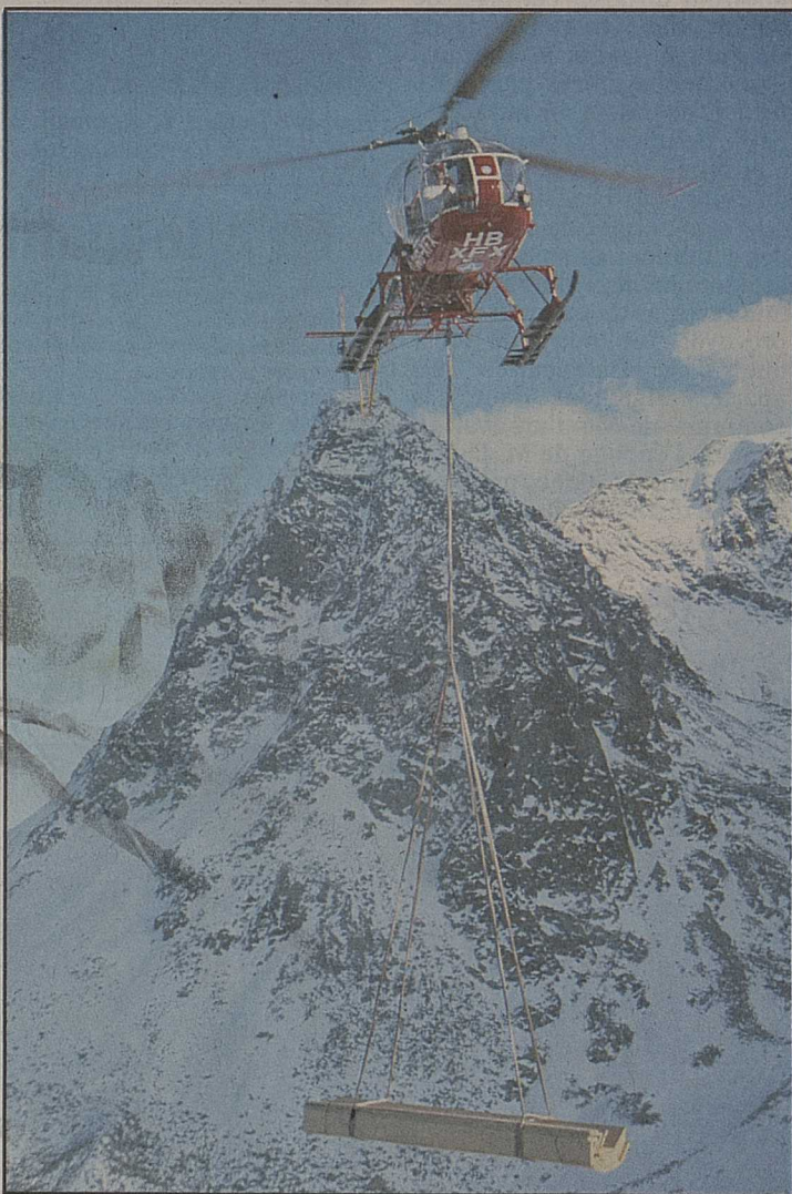
Quelques minutes de vol, la dextérité d'un pilote expérimenté, et la charpente se trouve à la porte de la cabane.
