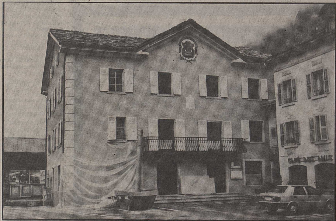
Les travaux de restauration des bureaux communaux seront probablement terminés plus tôt que prévu: on en a tenu compte dans la décision d'accorder des crédits complémentaires à la Municipalité bagnarde.
