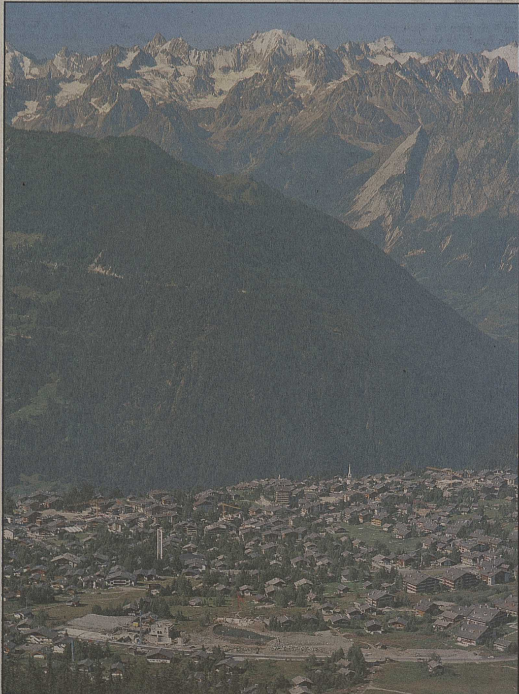
C'est au cœur de la station que se construit le Hameau de Verbier. Le chantier, d'une longueur de 350 mètres, en dit long sur l'importance de ce projet. Photo Michel Darbellay
