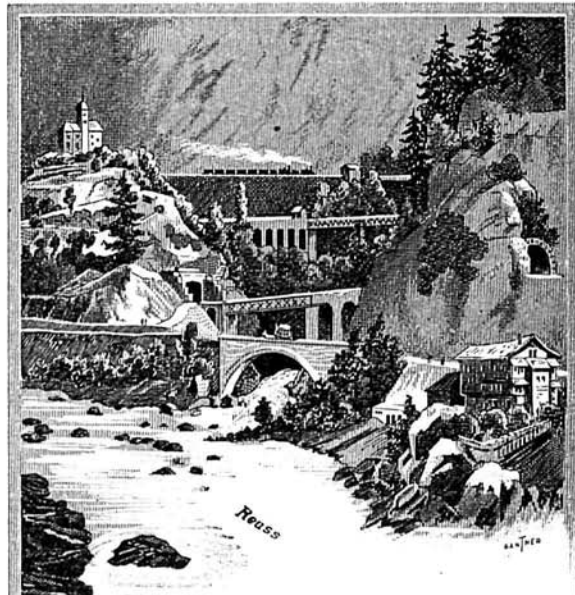
Fig. 72. — Ponts et tunnels du chemin de fer à Wassen. (Voir à figure ci-contre.)
