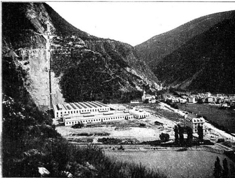
Fig. 22. — Les usines de Chippis.
