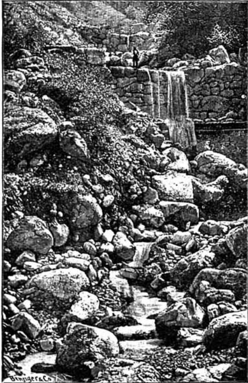
Fig. 135. — Endiguement d'un torrent de montagne.
