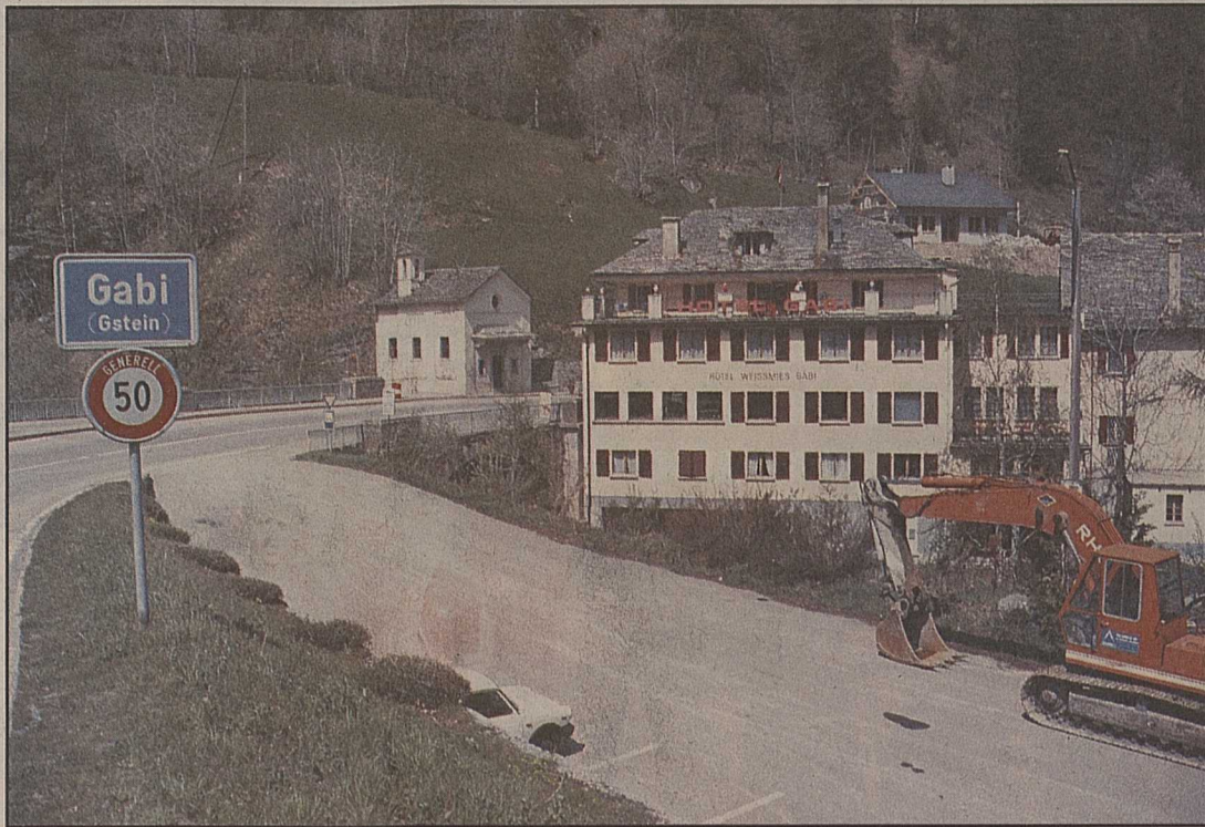
Coupant le hameau en deux, la route internationale sera bientôt déplacée.
