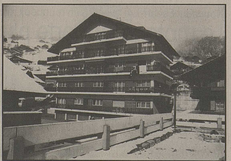
L'immeuble où les locataires sont le plus exposés aux bruits nocturnes.
