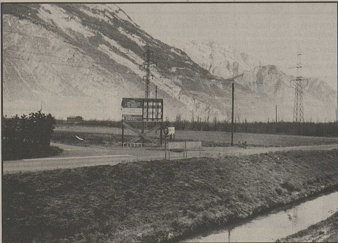
Une vue de l'emplacement de la future usine.
