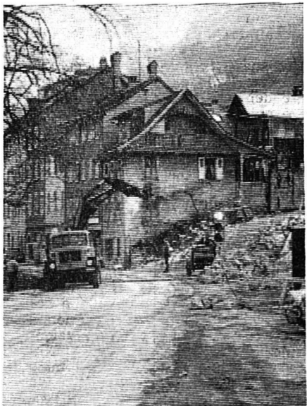
Notre photo: Une vue des travaux en face du café Helvétia.
