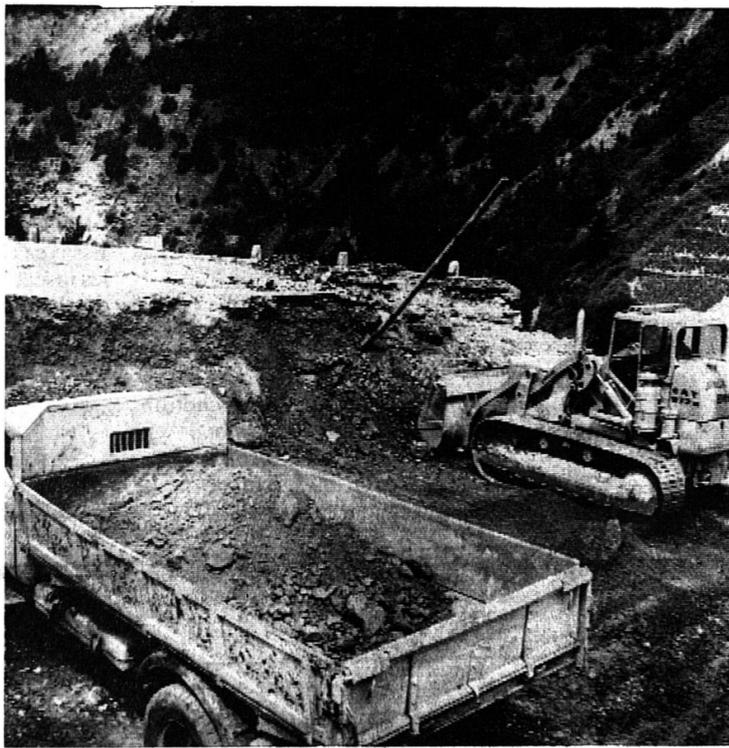
LES VALETTES — Un puissant bulldozer s'attaque maintenant à un tronçon de la vieille route d'Entremont pour faire place à la nouvelle chaussée qui passera quelque dix mètres plus bas. Les matériaux récupérés sont transportés par camions dans la région de la gare de Bovernier.
