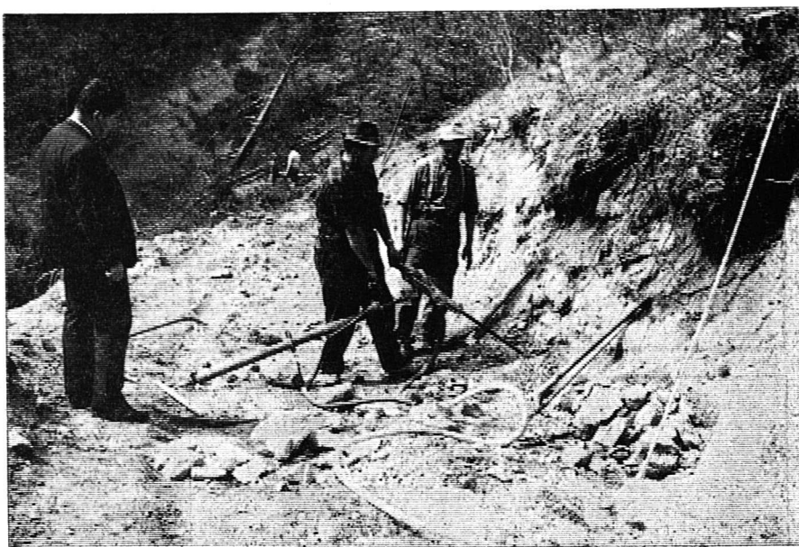
Peu de minages dans ce terrain pourtant très en pente. Le travail pourra se faire en général à l'aide d'un bulldozer seulement. Nous voyons ici le vice-président de la commune de Vollèges, M. Sylvain Biolaz, de Vens, lors d'une inspection.
