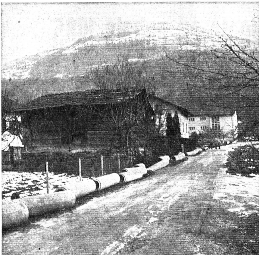
Dans toutes les rues et ruelles du village, un bataillon de « conduite » en béton, attendent que les fouilles soient ouvertes.
