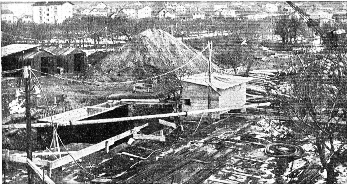
Une vue des premiers travaux de la station d'épuration.
