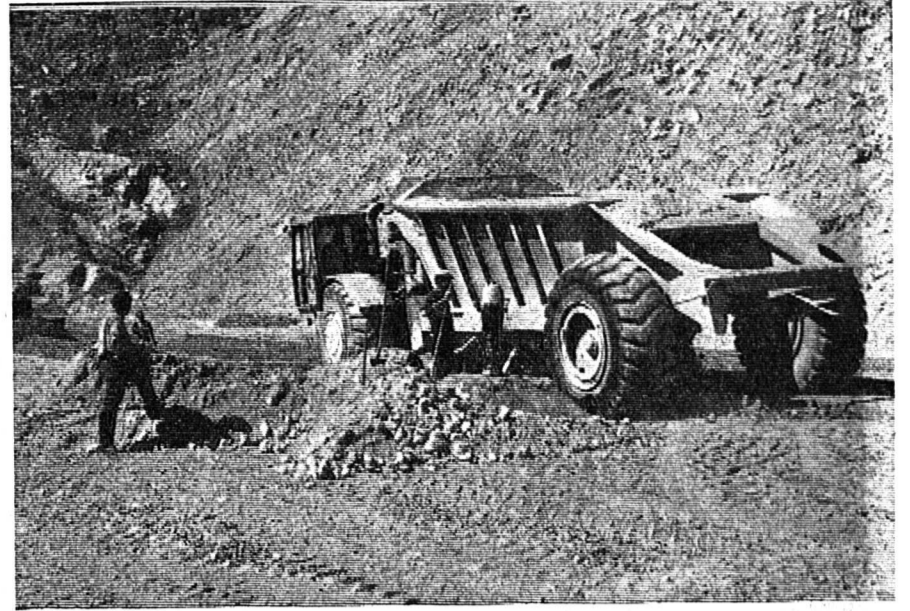
L'un des nombreux mastodontes qui animent ce chantier
