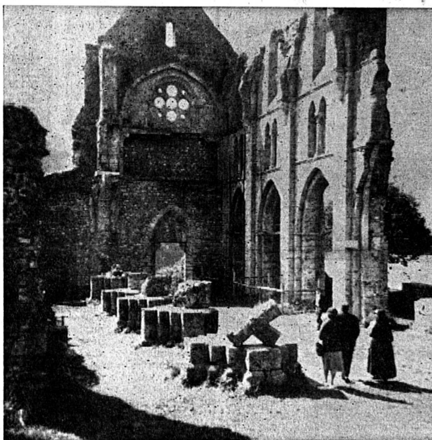
Les ruines de l'Abbaye après le déblaiement.
