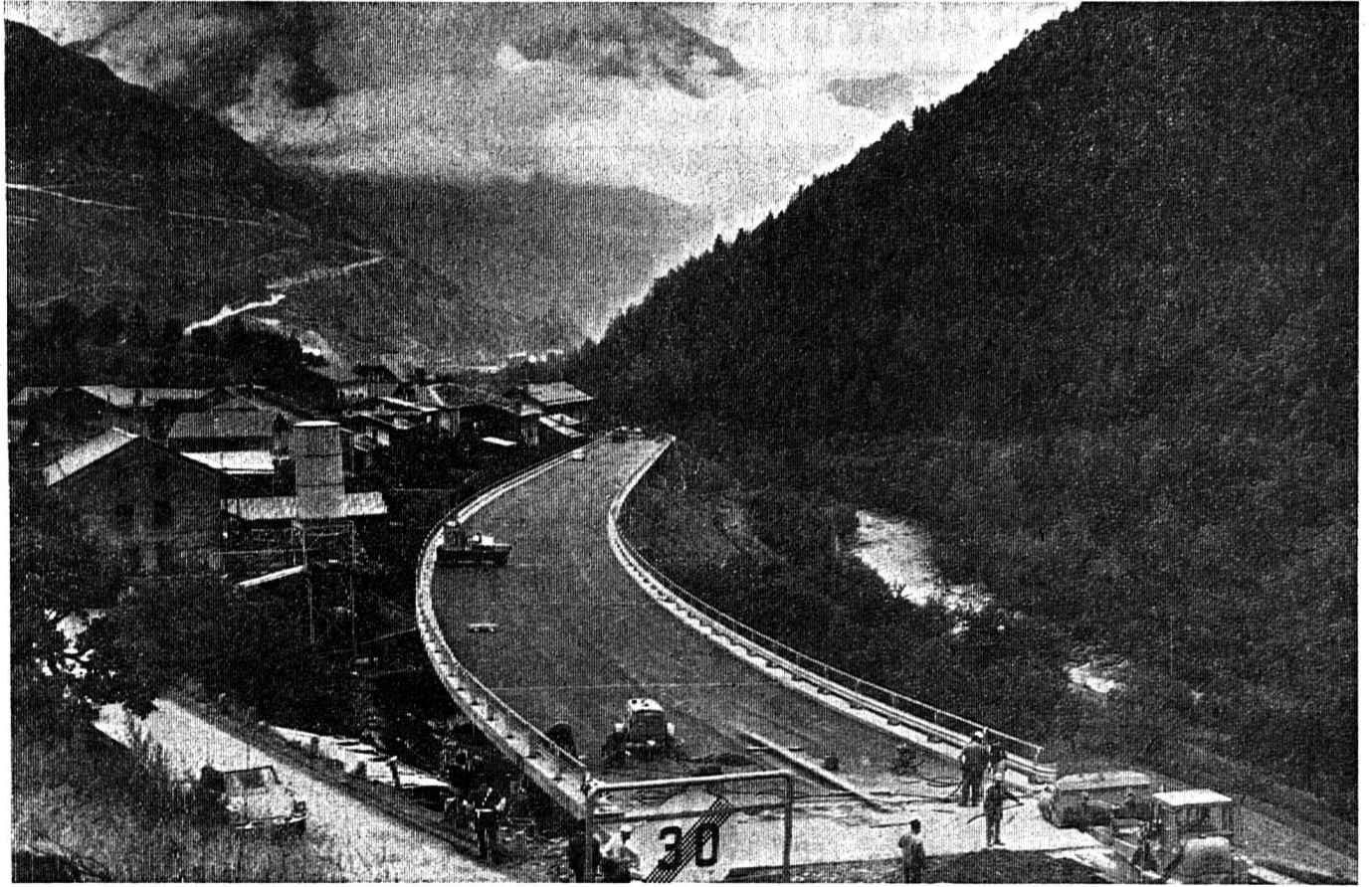
Le viaduc du Brocard vu en enfilade depuis l'amont.
