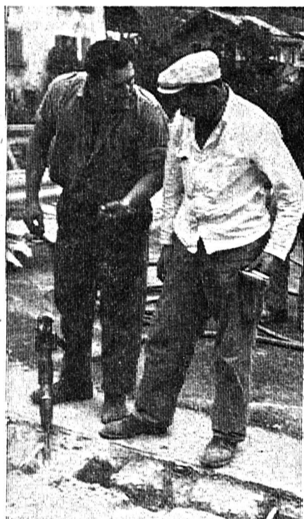
A droite, M. Gérard Emery de Lens, le contremaître qui conduisit les travaux, donne ses ordres à un ouvrier.
