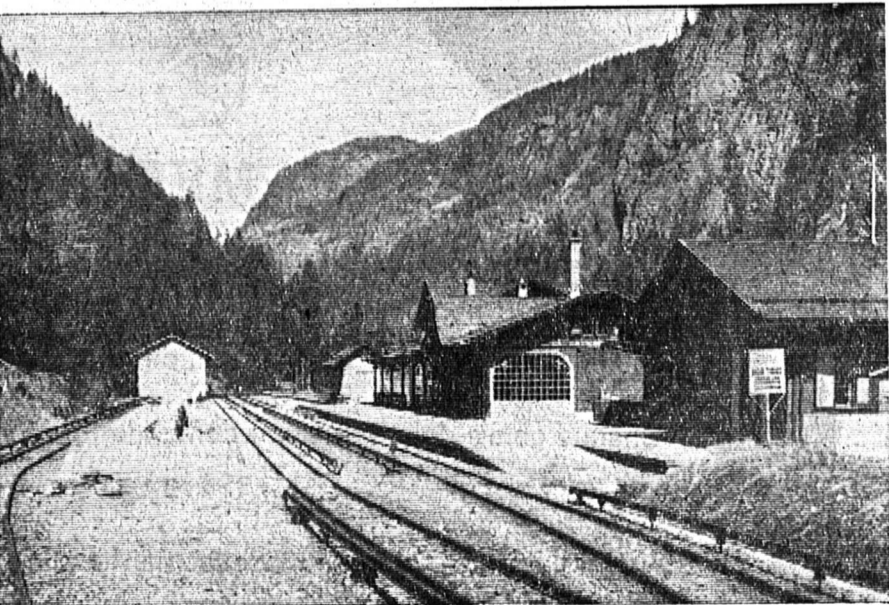
La gare de Châtelard
