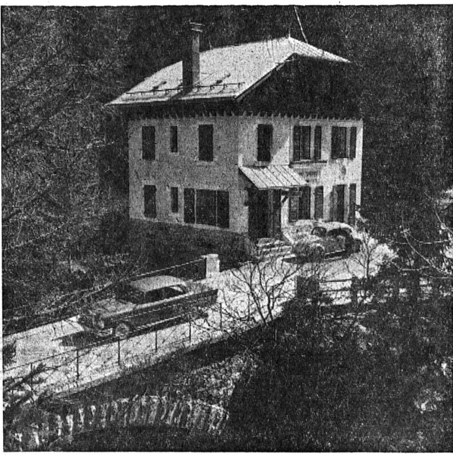
On remarque qu'il y a actuellement peu de place autour du poste de douane français de Châtelard pour permettre le contrôle de marchandises, surtout à l'époque où l'on enregistre une grosse circulation. Néanmoins de vastes terrains se trouvant en amont pourraient semble-t-il être aménagés à cet effet.
