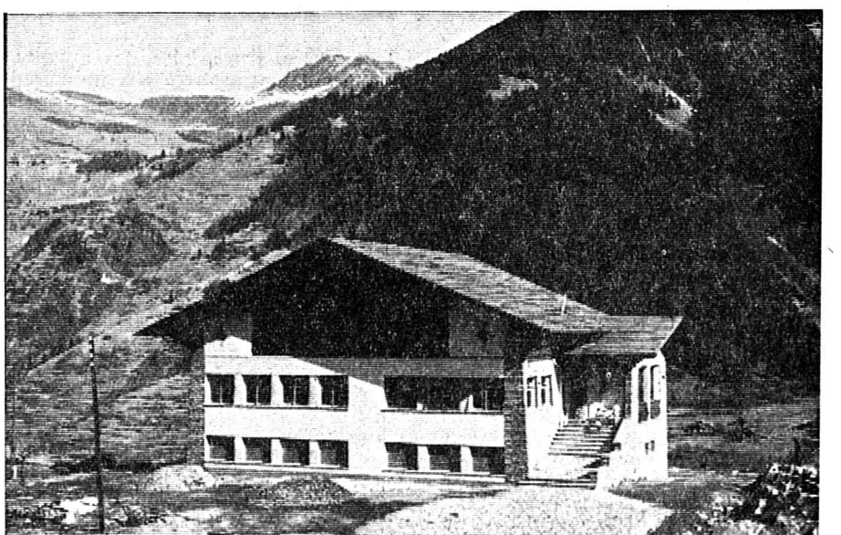
... et la maison d'école. La démolition de l'ancienne permettra de créer une place au milieu du village.
