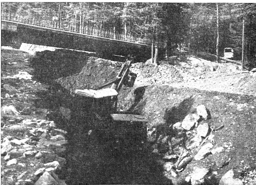
Des galets volumineux constituent autant d'obstacles à la coulée semi-liquide, que la pente se réduit davantage. Cette photo a été prise sous le pont-route au moment du curage, en 1961.
