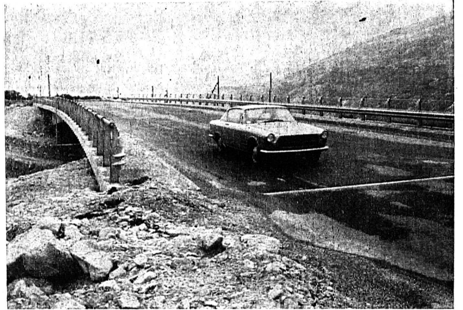
Le 5 juin 1961, un torrent de boue et d'eau emportait l'ancien pont sur l'Iligraben, à proximité de Susten. Sur cette route nationale, le trafic dut être détourné par Loèche. Ce ne sera plus le cas maintenant, puisque un nouveau pont vient d'être mis en service depuis peu (notre photo).
