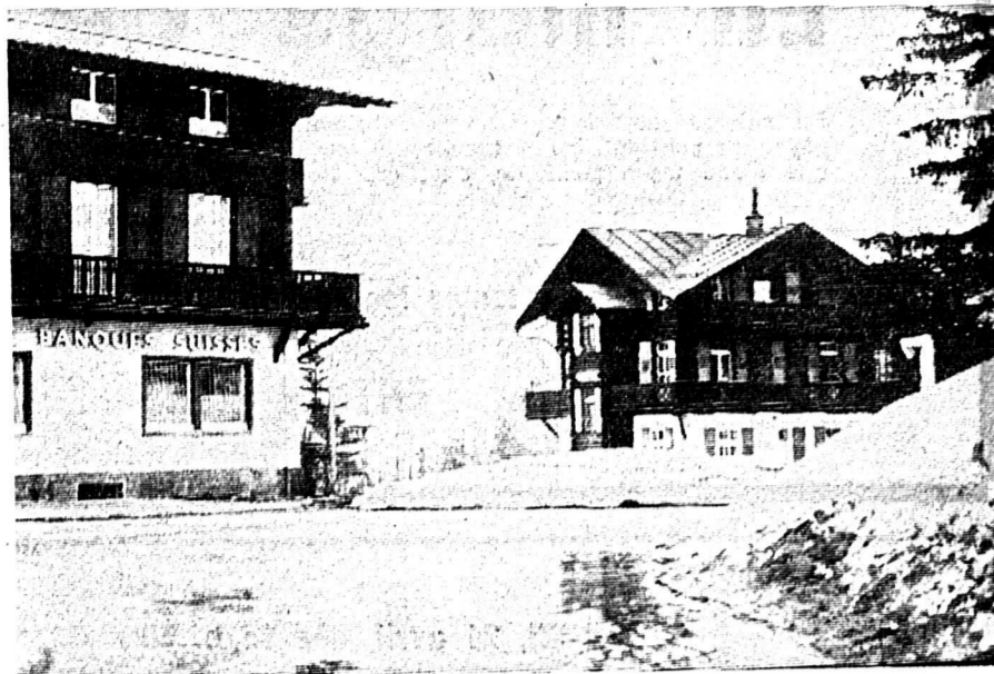
Le centre de Montana fait peau neuve ; la nouvelle artère aboutira entre ces deux maisons, dont celle de droite, l'Hôtel Gentiana, sera remplacée par un bloc.
