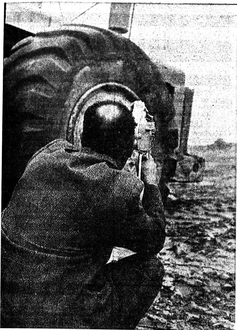
Ci-dessus : les engins utilisés sur le chantier de Lonay-Denges sont à la mesure des travaux qui comprennent l'extraction, le transport et le compactage de 700 000 m 3 de limon et de sable. 11 scrapers, 4 bulldozers et 3 rouleaux transportent 10 000 m 3 de terre par jour à la vitesse de croisière de 60 km/h. dans le terrain.
