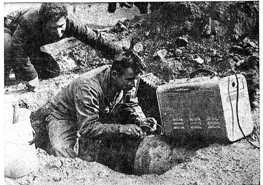
On sait qu'une bonne partie de l'oléoduc, qui apportera aux futures raffineries de Collobey le pétrole à traiter, est en bonne voie d'exécution. Sur notre photo on peut voir des contrôleurs du Service fédéral pour le contrôle des matériaux procéder à un examen des soudures de l'oléoduc (de leur solidité surtout) au moyen d'appareils à ultra-sons.
