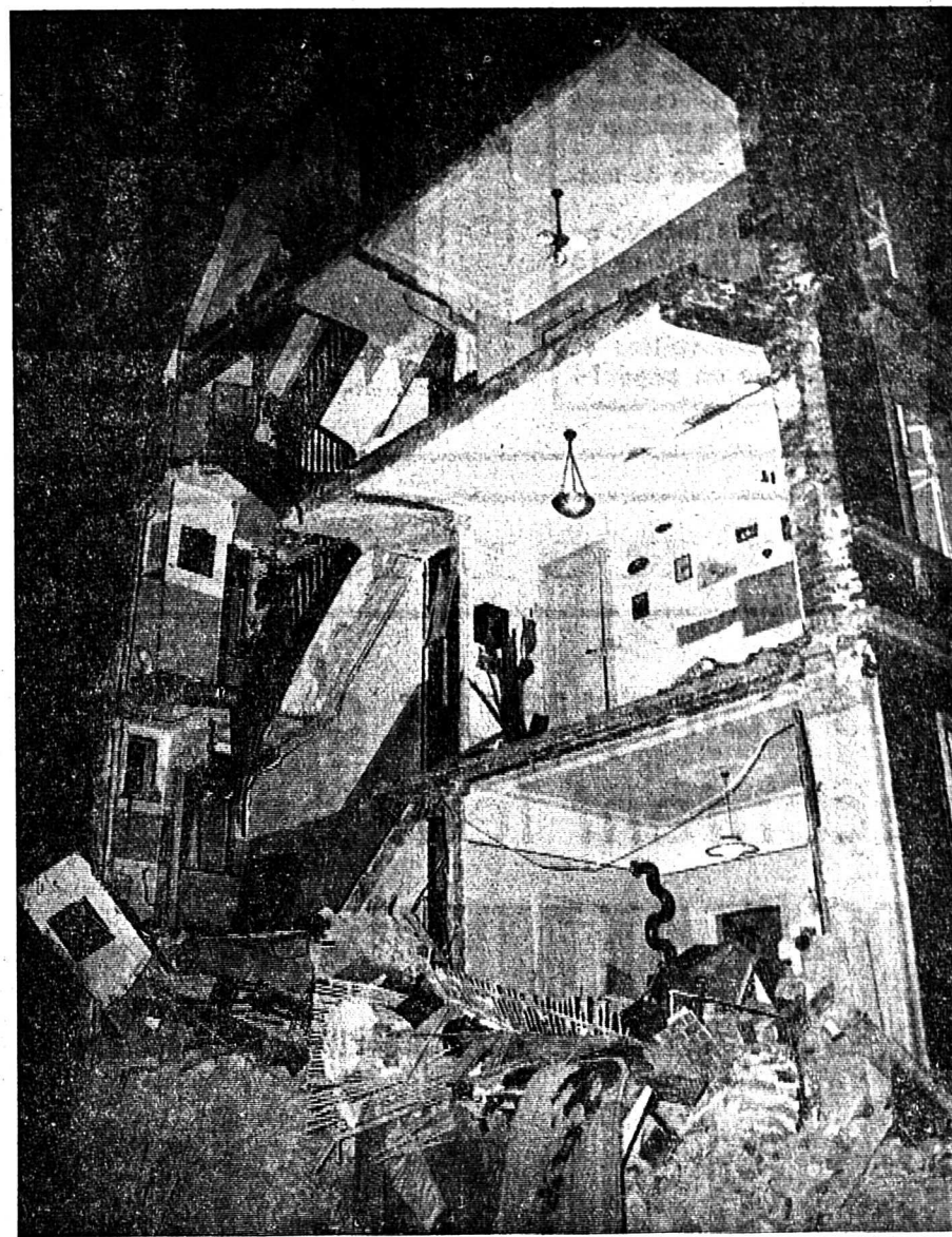
Un immeuble de la Gundeldingerstrasse retenu par de grosses poutres, en raison d'un vide existant entre les deux maisons, s'est effondré, mardi vers 20 heures. Dans la journée, des locataires de cet immeuble de quatre étages, avaient entendu un curieux bruit provenant des murs. Ils en référèrent à un contremaitre qui les tranquillisa. Soudain, vers le soir, dans un bruit infernal, le mur s'écroula. Par un hasard miraculeux, personne ne fut blessé. Les pompiers vinrent très nombreux sur les lieux et, au moyen d'échelles, évacuèrent les locataires des 2ème, 3ème et 4ème étages, qui furent recueillis chez des amis ou à l'hôtel. L'ambulance municipale était également sur place. La police barra les rues voisines tandis que les entreprises des transports en commun ordonnaient les détournements nécessaires et remplaçaient les trams par des autobus. Il va de soi que les locataires des immeubles voisins ont été évacués.
