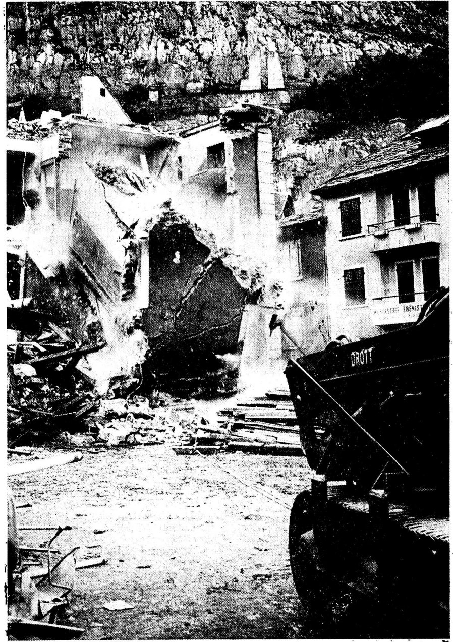
Voici le moment précis où tout un angle de la maison d'école s'écroule avec fracas et poussière. Le trax militaire du premier plan l'a littéralement arraché au moyen d'un câble d'acier. Préalablement les hommes de la P.A. avaient affaibli les fondements de ces murs par de profondes excavations. Des lances d'incendie furent simultanément mises en action pour diminuer la poussière. (Photo A. L., Nouvelliste)
