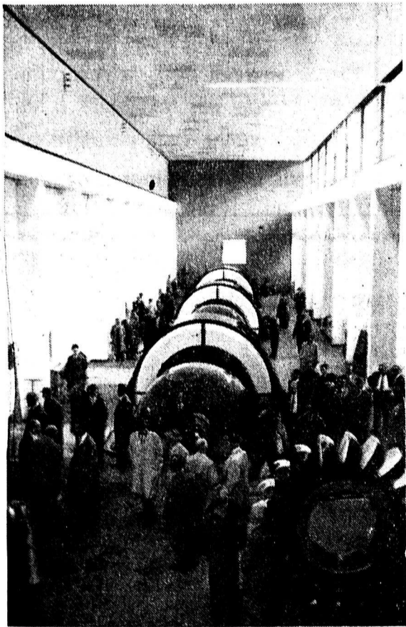
On visite la centrale de Vissoie. Cette photo a été prise depuis la salle des commandes qui domine toute la halle que l'on peut voir à travers une grande baie vitrée. On remarque les 3 groupes de turbines Pelton à 2 roues avec 2 jets par roue, dont le débit est de 4 m 3 /sec.
