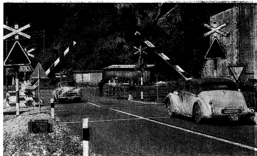
Le nouveau système de barrières au passage à niveau de la Porte-du-Scex. On remarque bien les demi-barrières permettant le passage à une voiture déjà engagée à la traversée de la ligne CFF.
