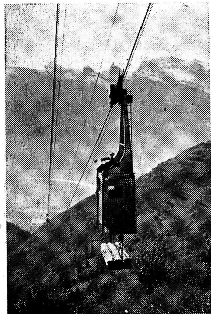
La cabine du téléphérique à son entrée en gare terminale. Elle transporte un chargement de briques. Une jeep peut également être ainsi amenée à Isérables. Tout ce qui vient de la plaine d'ailleurs monte au long de ces câbles.
