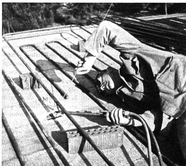
Pose et soudure à l'autogène des serpentins du chauffage par rayonnement, noyés dans les dalles en béton.
