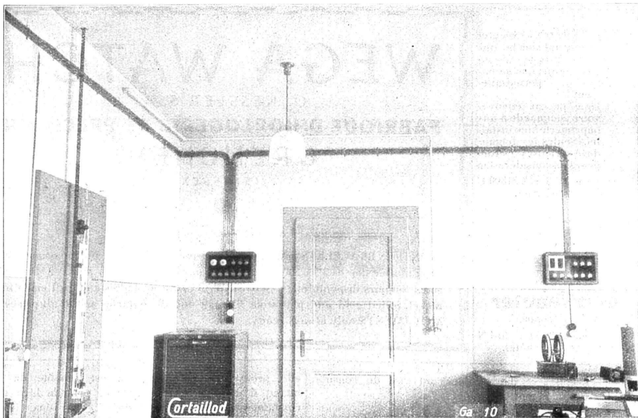
Installation dans une salle d'enseignement
