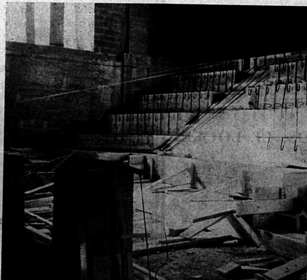
Socles et gradins en béton armé du grand auditoire.
