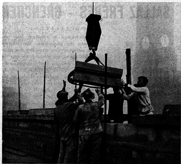
Pose de la corniche.
