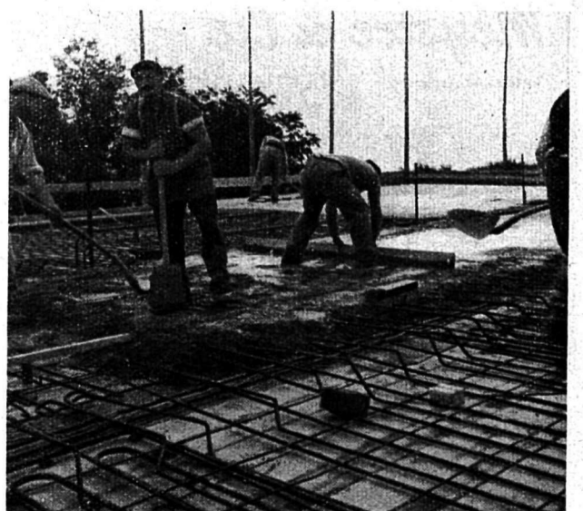
Armature et bétonnage de la dalle du rez-de-chaussée.
