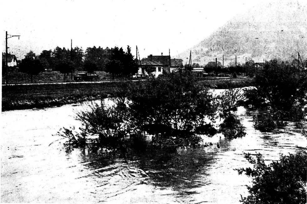
Les pluies diluviennes de ces derniers jours ont provoqué de grosses inondations au Val-de-Travers où l'Areuse a débordé. — Notre photo: les inondations entre Môtiers et Fleurier.
